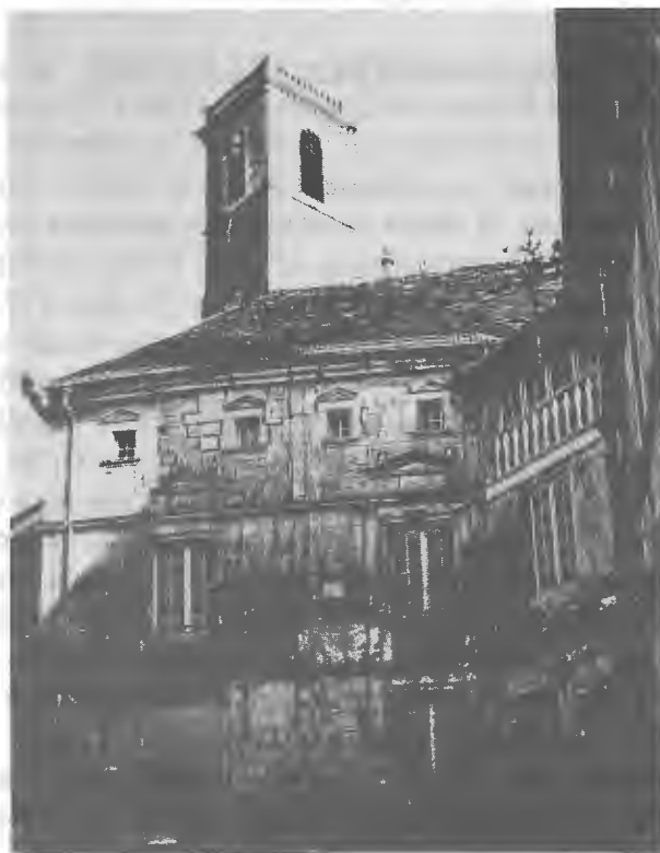
L'ancienne maison dite du bailli
